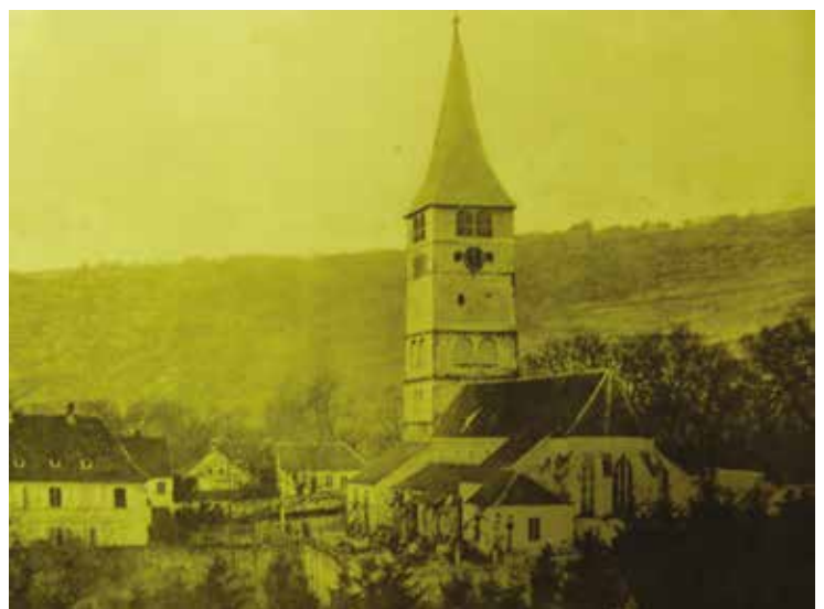
Vue de l'ancienne église romane depuis l'Est (Archives de la SHME)
